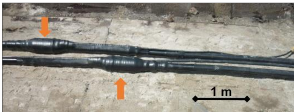
Abbildung 7: Muffe (Pfeilmarkierung) vor Wiederverfüllung des Leitungsgrabens 7
